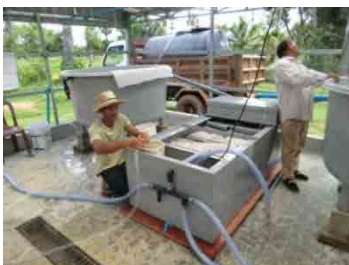
濾過槽への配管作業 農家 C (Van Po 氏) サイト
