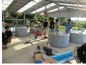
水槽類の設置作業 農家 B (Hang Heang 氏) サイト
