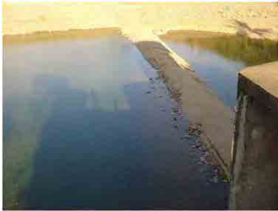
頭首工固定堰部分
