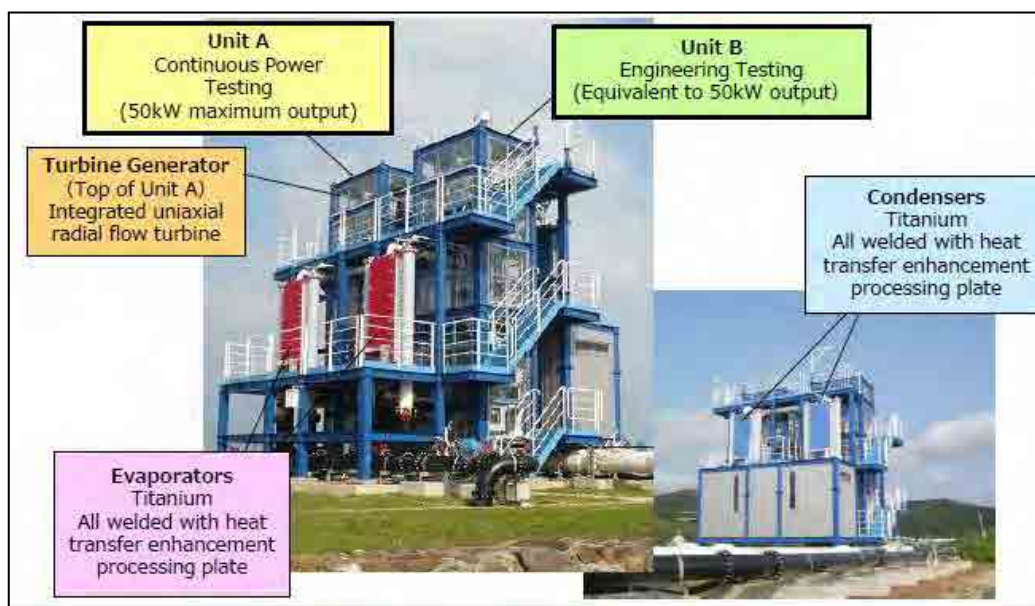
図 9 沖縄県海洋深層水研究所（久米島）に設置・稼働中の OTEC 実証設備
