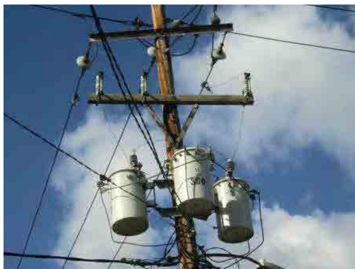
図 9 柱上変圧器（ドミニカ：ABB 製（アメリカ製））
