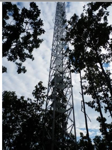
パヤオ大学内にプロジェクトが建設した フラックス観測塔（4）
