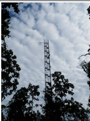
パヤオ大学内にプロジェクトが建設した フラックス観測塔（3）
