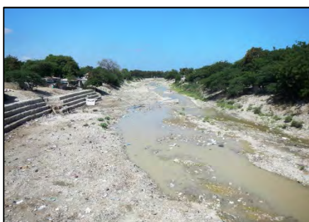
Photo 2-2-2 Site du pont de la Croix-des-Missions
