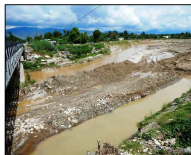
Photo 2-2-3 Site du pont de la Route Neuve
