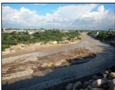
Photo 2-2-1 Site du pont Tabar (En amont du pont de la Croix-des-M)
