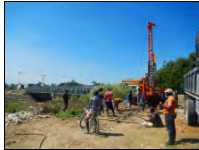
写真 2-2-7 右岸ボーリング調査状況
