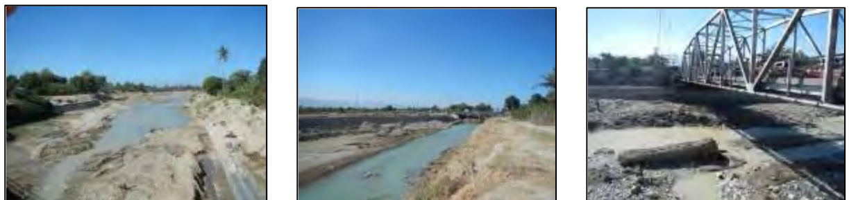
写真 2-2-5 護岸整備状況
