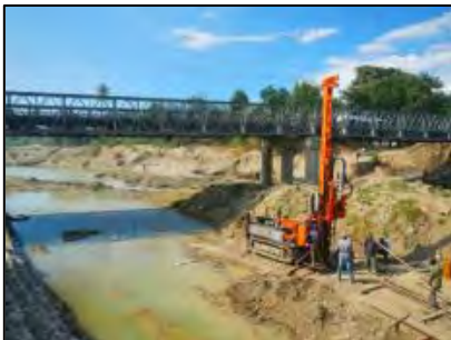
写真 2-2-6 河川内ボーリング調査状況
