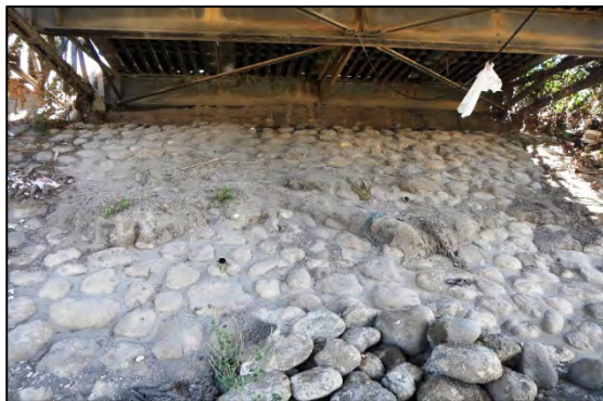
写真 - 27 : 橋台前面の石張り護岸 (A2)
