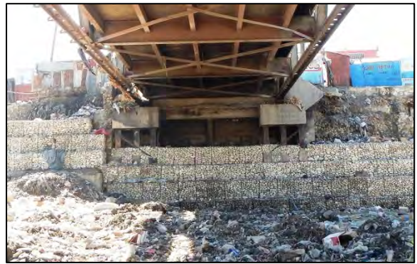
写真 - 10 : ガビオンで修復された護岸
