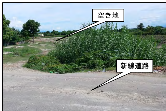
写真 - 31 : 新線沿道の状況
