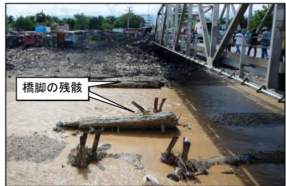
写真 - 12 : 旧鉄道の橋脚の残骸
