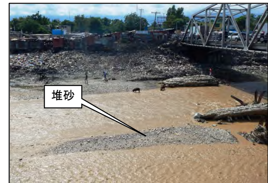
写真 - 14 : 乾期のグリセ川の状況（橋梁の上流側）
