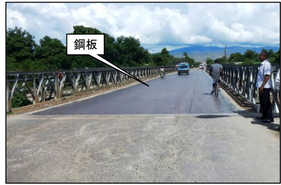
写真 - 18 : 新線橋梁全景 (正面)
