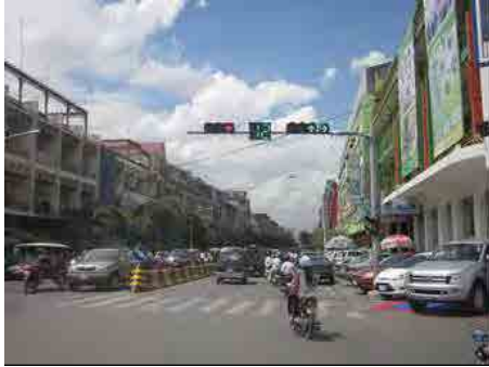
写真-1：プノンペンで標準的な既設信号灯器。矢印表示とカウンタダウタイマーが設置されている。
