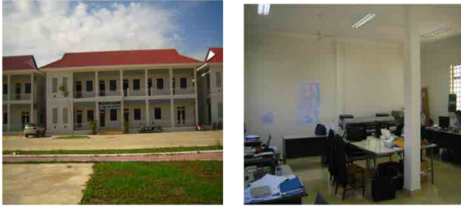
図 15：建物外観と現況室内
