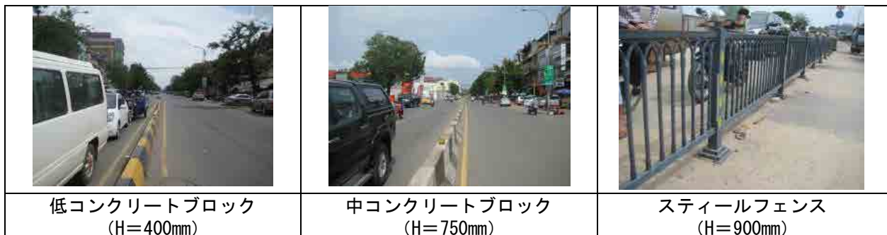
図 22：調査対象交差点の既存の車線分離構造物
