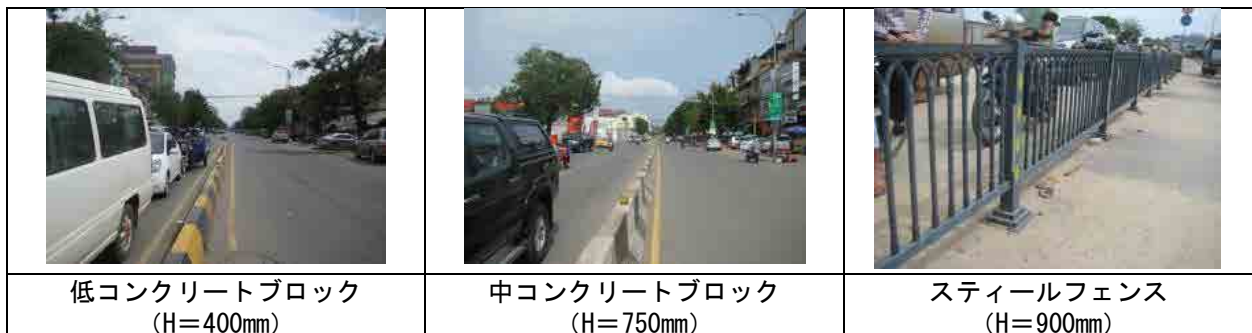
図 22：調査対象交差点の既存の車線分離構造物
