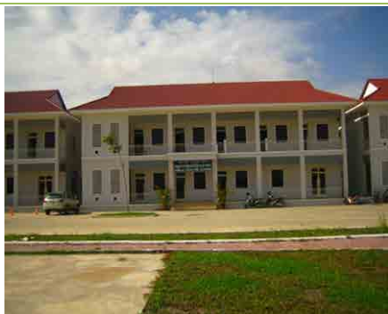
写真-5：交通管制センター候補建屋。この建屋はDPWT 敷地内の別館建屋で、この一階に交通管制センター導入を予定している。
