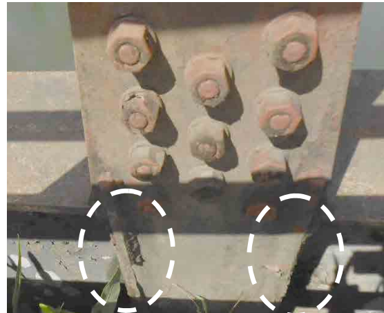
写真 2.1.5 吊材の疲労クラック補強
