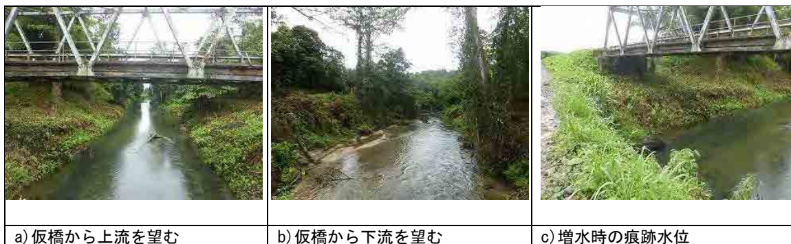
図 3.2.5 アウム橋周辺の河道状況
