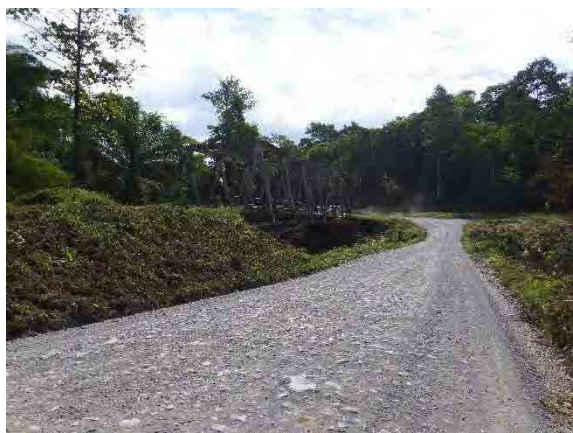
6. 既設橋と迂回道路
