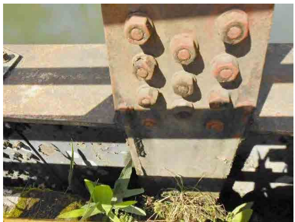
6. 鉛直材ガセットの亀裂補修・補強
