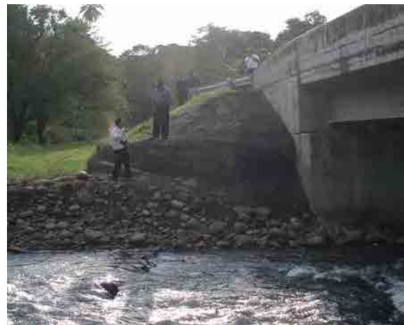
写真 2.1.14 Warakapis 橋復旧状況
