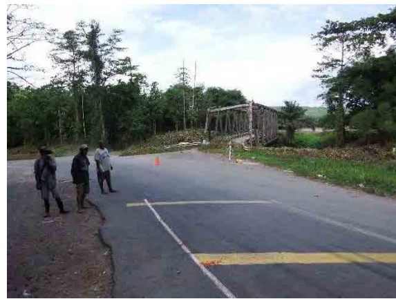
2. 橋梁左岸側へのアプローチ部
