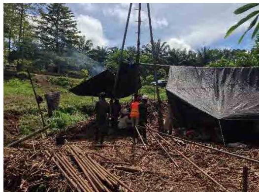
写真 2.2.2 カピウラ右岸ボーリング
