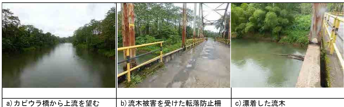
図 3.2.4 カピウラ橋周辺の河道状況
