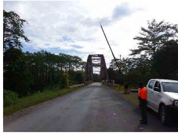
2. 橋梁左岸側へのアプローチ部
