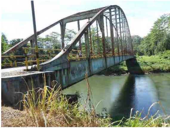
1. 既設橋の現況
