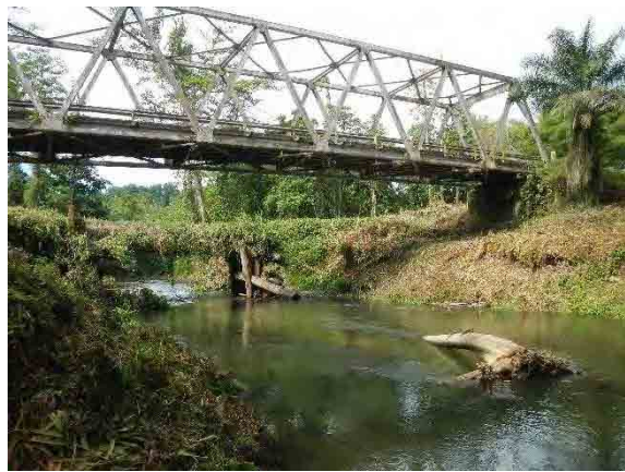
1. 既設橋の現況
