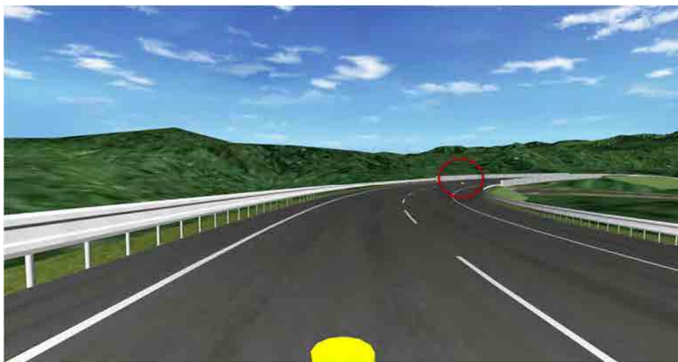
図 3.2.13 起点側からアウム橋方向 (橋梁まで 70m)
