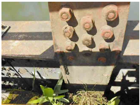
6. 鉛直材ガセットの亀裂補修・補強
