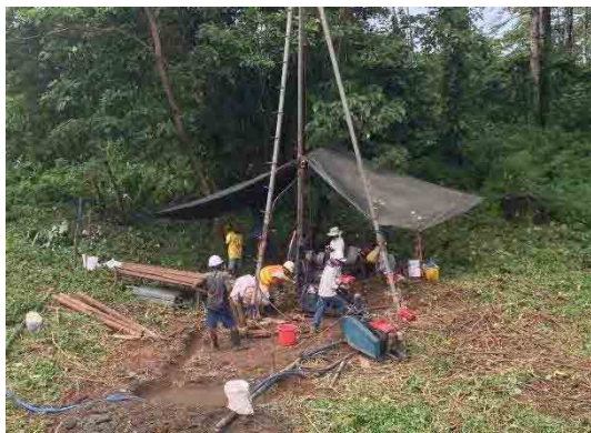
写真 2.2.1 カピウラ左岸ボーリング
