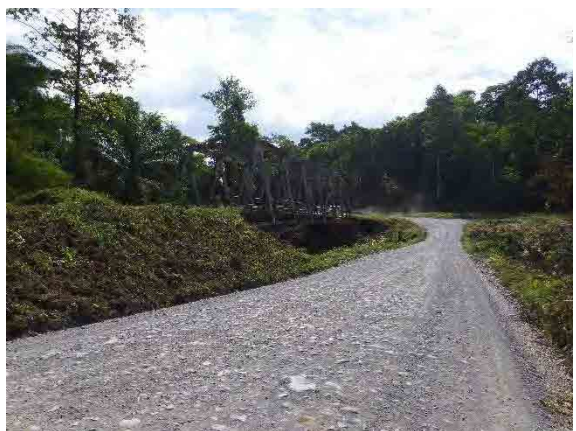
6. 既設橋と迂回道路
