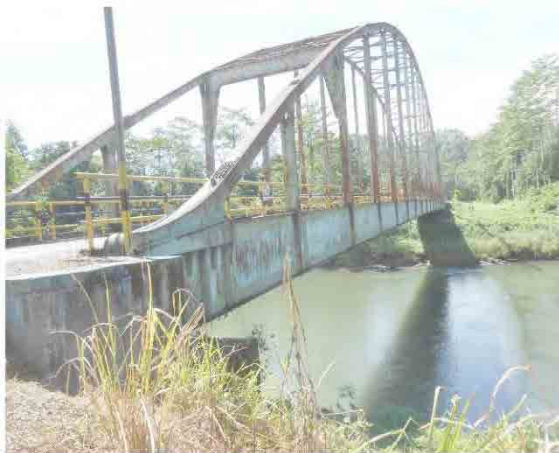
写真 2.1.1 カピウラ橋全景
