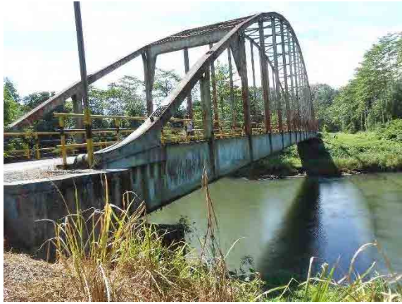
1. 既設橋の現況
