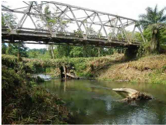
1. 既設橋の現況
