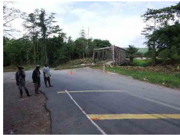
2. 橋梁左岸側へのアプローチ部
