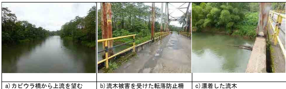
図 3.2.4 カピウラ橋周辺の河道状況
