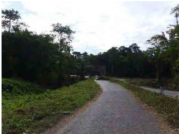
3. 橋梁右岸側へのアプローチ部
