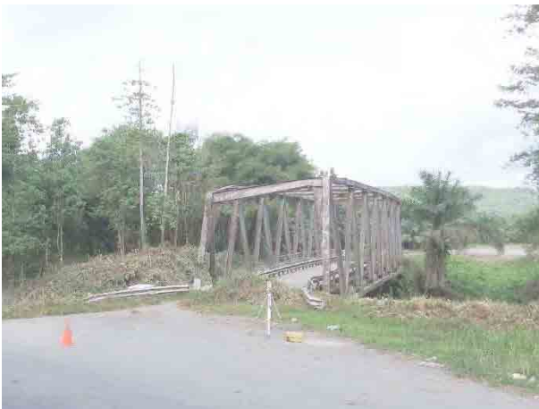
写真 2.1.8 アウム橋全景
