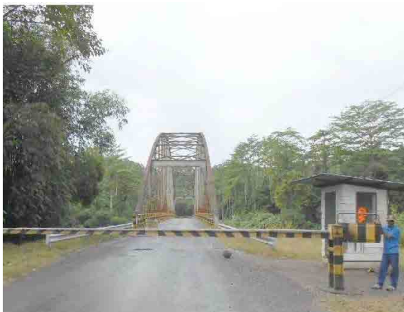
写真 2.1.4 カピウラ橋のゲート
