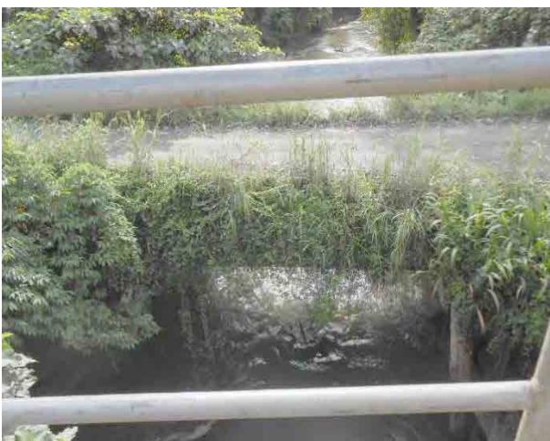
写真 2.1.10 迂回路の丸太橋
