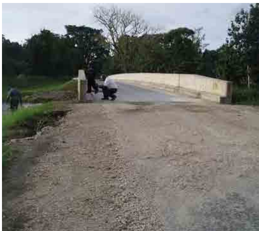
写真 2.1.13 Retaovei 橋復旧状況
