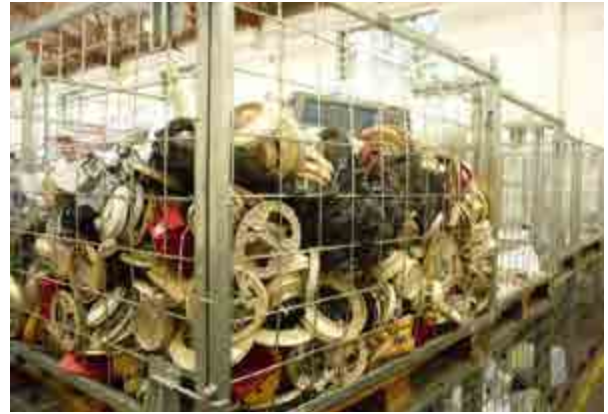
手解体されたPC部品
