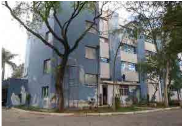
改装工事中の AMLURB の概観
