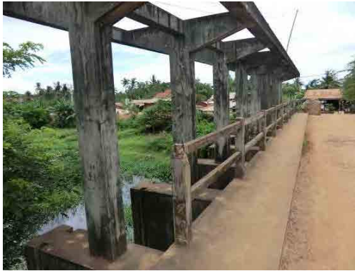
写真 9: Ream Korn 水門。取水口が高いため採水できず、水門前は沼と化して水草が繁茂している。
