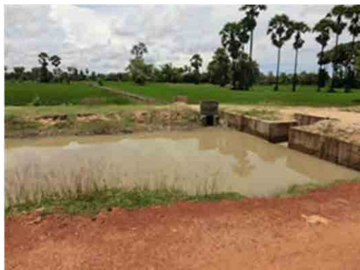
写真2: TSC2モデルサイト。2次水路の補修とともに3次水路もコンクリート舗装された。雨期稲作の後には奥のココナツから砂糖原料となる樹液を採取する。
