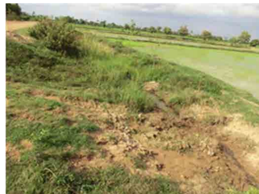
写真 5: 2 次水路の一部。圃場へ入りやすくするため堤をくずして通路を作っている。
