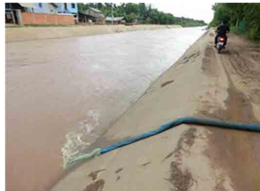
写真 1:2000 年初頭に無償資金協力により補修された 1 次水路。近傍の圃場ではポンプを用いて 1 次水路から直接取水したり配水したりしている。農民の最大の要望は堤の道路機能の整備である。
