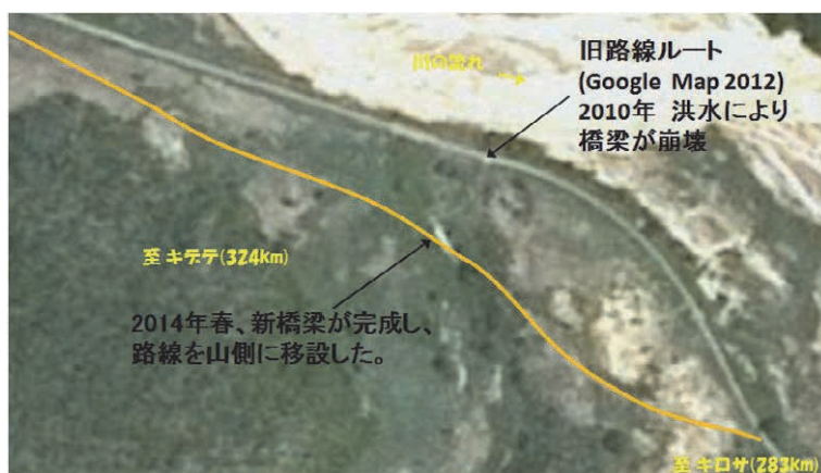
2010年、洪水により鉄道橋(図中の白線部)が崩壊。崩壊した橋梁の仮復旧、並びに山側での新橋建設を実施し、2014年春に山側へのルート移設が完了。
