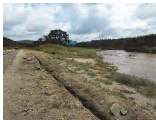
図 2-40 光ファイバーケーブル敷設工事 (293 km 地点)
