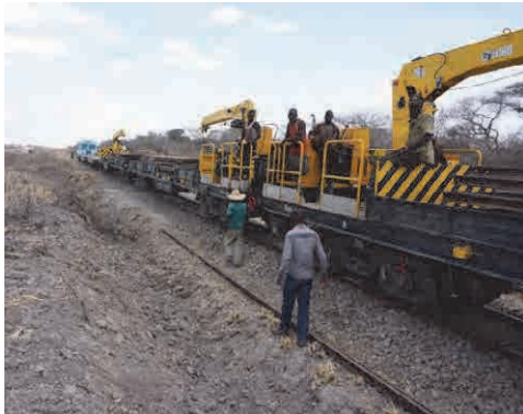
図 2-23 659.8 km 地点におけるレール交換工事の様子
