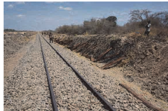
図 2-23 659.8 km 地点におけるレール交換工事の様子
