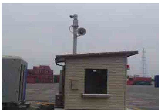
図 I. 1. 4-3 場内放送設備 (参考)
