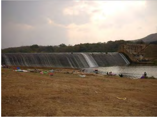
Kamuzu I Dam
