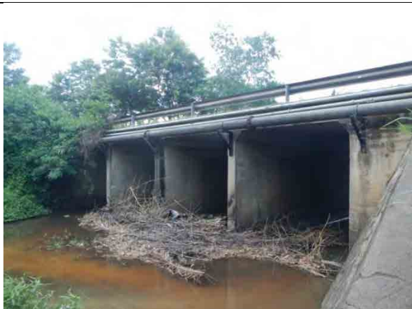
アシンアンドエのボックスカルバート通水断面の流木による阻害状況
