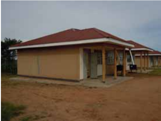
CDRET を通じて建設された アムル県職員宿舎
