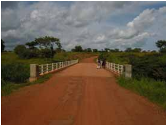
RRNPN を通じて建設された Toli 橋
