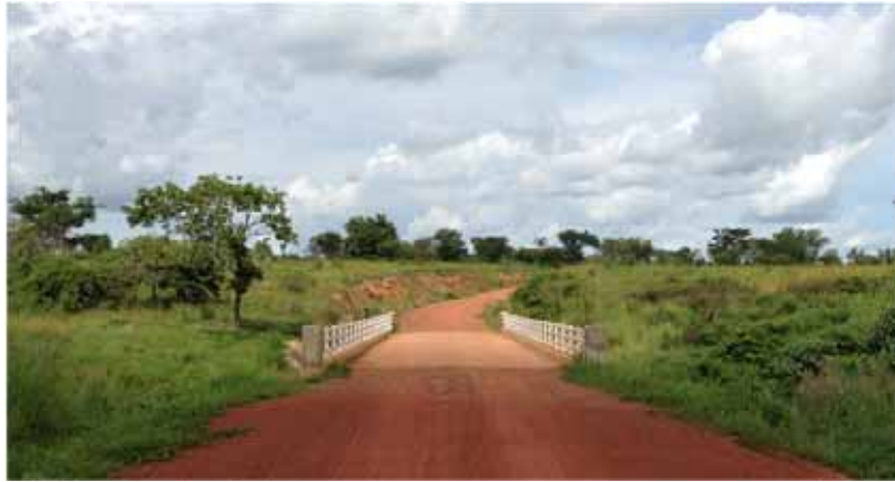
INDEP で建設した Ayago Bridge
