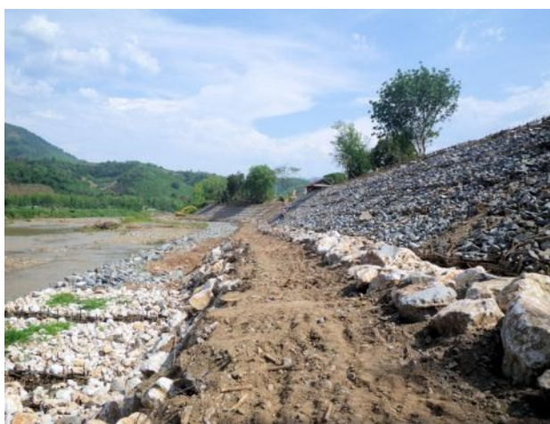
ルアンパバン県河岸侵食対策工完成後 2 (2014年5月)
