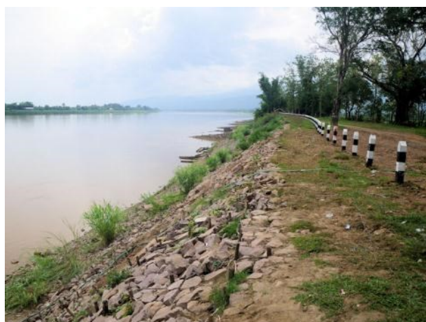
ボリカムサイ県河岸侵食対策工完成後 1 (2014年5月)
