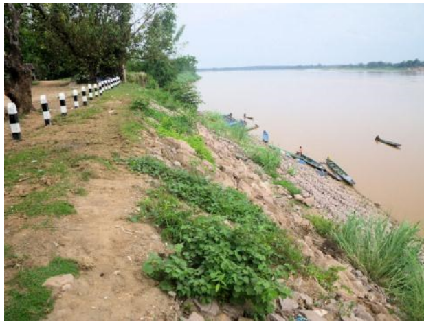
ボリカムサイ県河岸侵食対策工完成後 2 (2014年5月)
