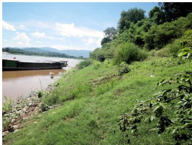
ボケオ県河岸侵食対策工完成後 1 (2014年5月)
