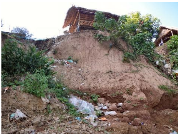
ルアンパバン県河岸侵食状況 1 (2010年12月)
