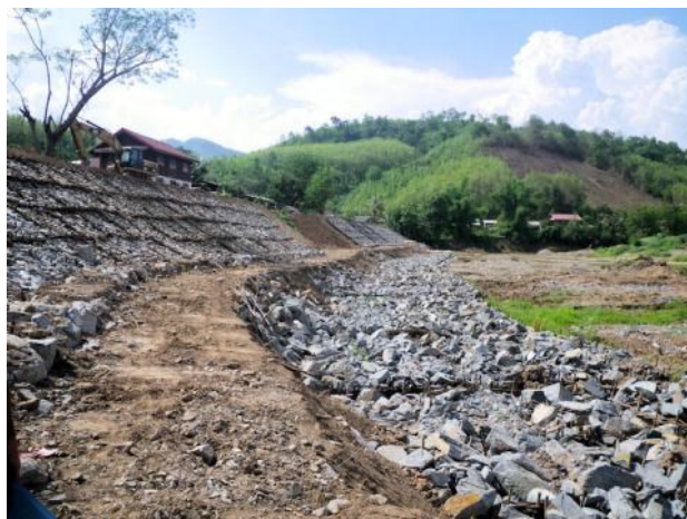
ルアンパバン県河岸侵食対策工完成後 1 (2014年5月)
