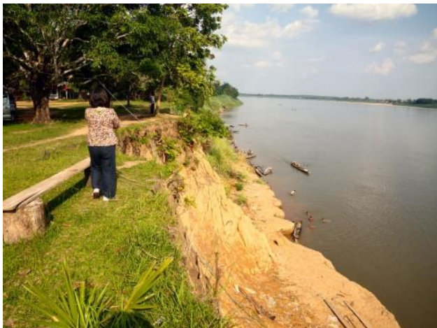
ボリカムサイ県河岸侵食状況 2 (2010年12月)
