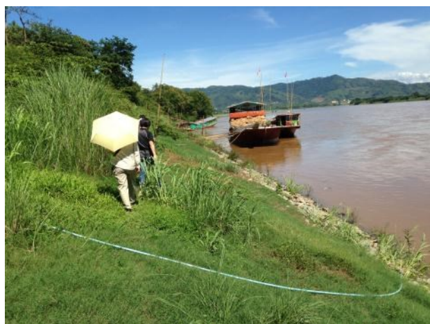
ボケオ県河岸侵食対策工完成後 2 (2014年5月)
