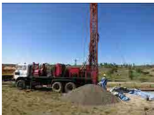
試掘調査（掘削）
