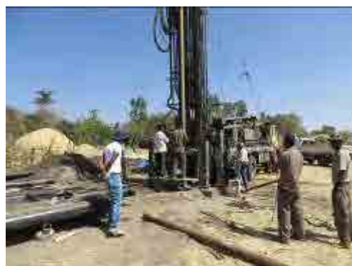
試掘調査（掘削）
