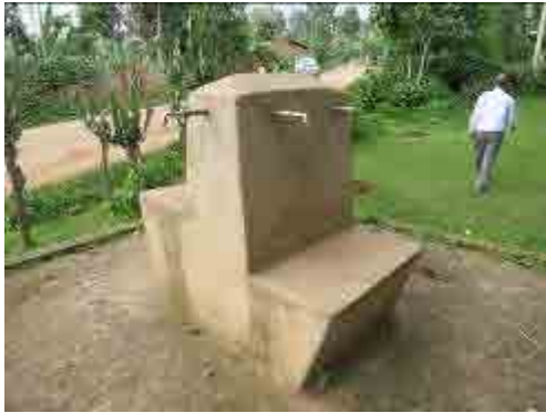
既存施設（公共水栓）
