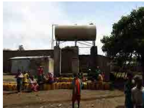
既存施設（高架式配水池）
