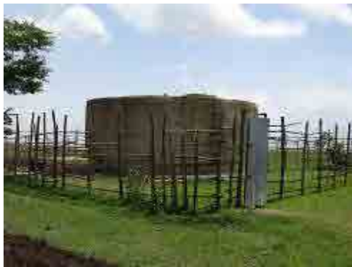
既存施設（地上式配水池）
