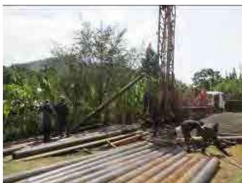
試掘調査（ケーシング挿入）
