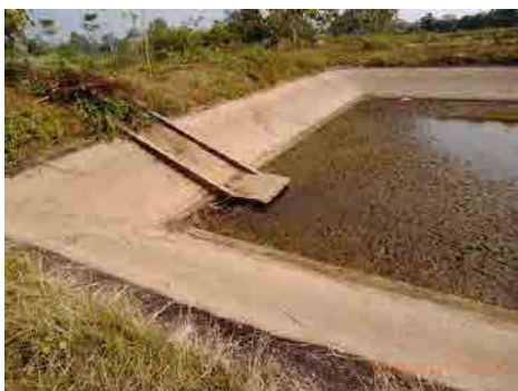
写真-5：NADC 漏水のため使用できない親魚/中間育成池
