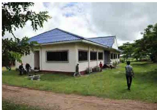
写真-1：NADC 既存事務棟
