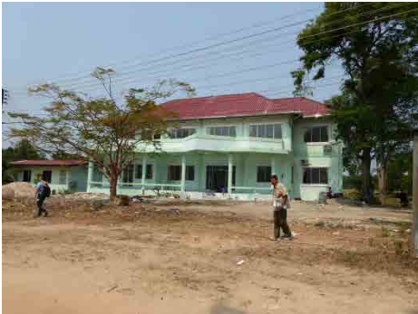
写真-11：LARReC の新事務所
