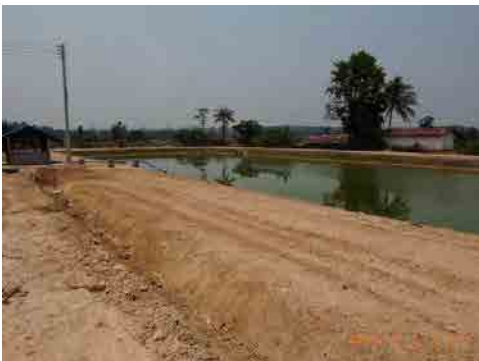
写真-7：NADC により造成された新貯水池
