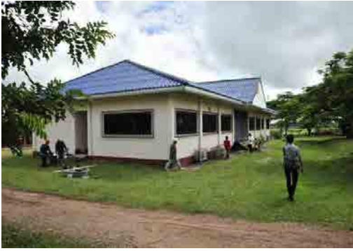
写真-1：NADC 既存事務棟
