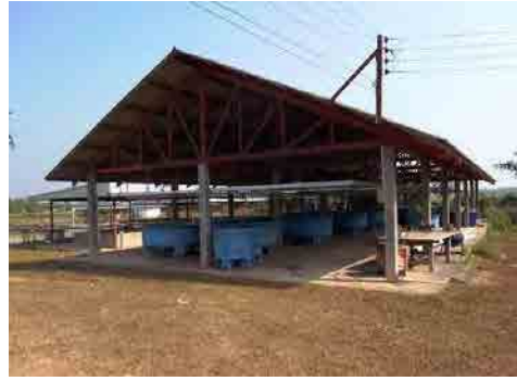
写真-2：NADC 種苗生産施設（給水設備の不具合があり使用されていない）
