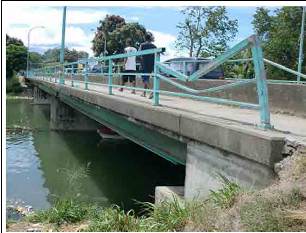
⑦新マタニコ橋（洪水前に撮影） 既存橋の健全性が確認されたため継続使用する。ただし、舗装、伸縮継手、高欄の壊れた部分は補修する。
