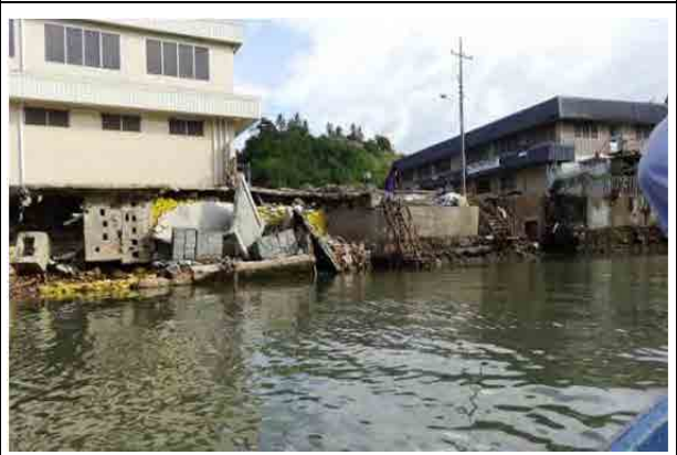
⑯旧マタニコ橋右岸 (洪水直後) 2014年4月の洪水により旧マタニコ橋は流失し、右岸側の護岸は浸食された。その後も復旧されていない (2014年8月時点)。
