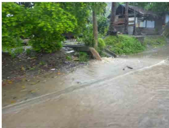
⑨山側からの排水状況（Sta. 1+500） 山側からの排水量が多いが、排水設備が不十分であるため、道路に溢れ出ている。
