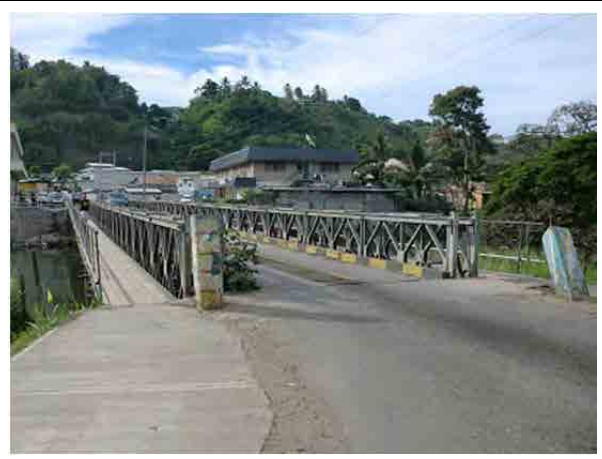
⑧旧マタニコ橋（洪水前に撮影） 2014年4月の洪水により流失し、ほとんど同じ形状のベイリー橋が応急的に復旧されている。
