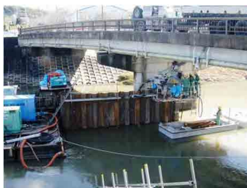
図 3-2-36 橋梁下での鋼矢板打設の例
