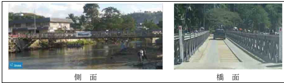
図 2-2-19 旧マタニコ橋の現橋写真
