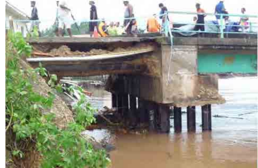
A2 橋台背面を橋梁の北側から撮影 (2014年4月4日)
