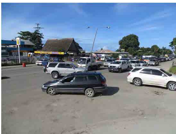
⑤ブラ交差点 (Sta. 2+500km) 信号機等の交通制御施設がないため、車両の錯綜が生じている。
