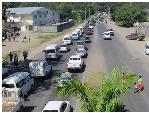
③新マタニコ橋付近 (Sta. 0+500km) 4車線道路に架かる新マタニコ橋での車線数が2車線であるため渋滞が発生している。
