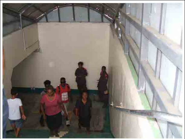
⑭横断地下道入口 (2014年8月時点) ホニアラ市役所が清掃、照明修理、警備員を配置し、歩行者の道路横断のために再開放した。(本プロジェクトの趣旨を理解したことによる。)
