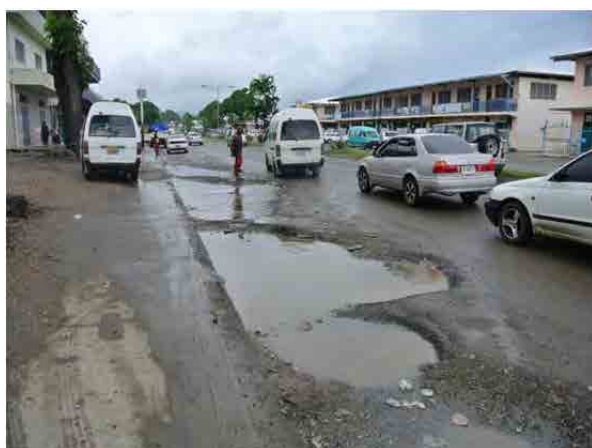
⑪バス停前の舗装損傷（Sta. 2+300） 排水設備の不備により、アスファルト舗装が破損し、雨水が路面に溜まっている。
