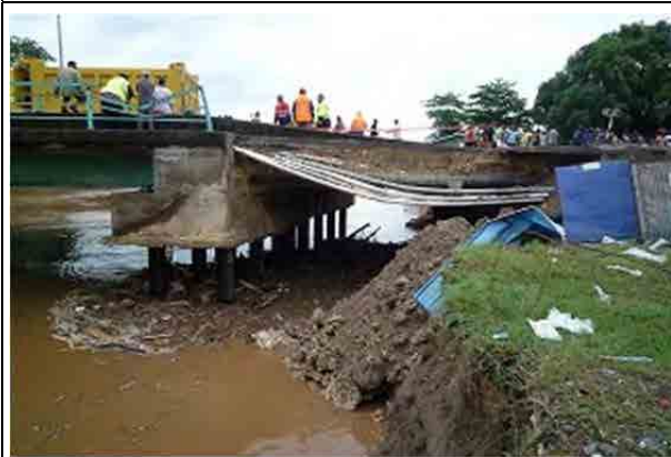
⑮新マタニコ橋 (洪水直後) 2014年4月の洪水により新マタニコ橋右岸側橋台の背面盛土が浸食され、一時通行できなくなったが、盛土により原形復旧されている。
