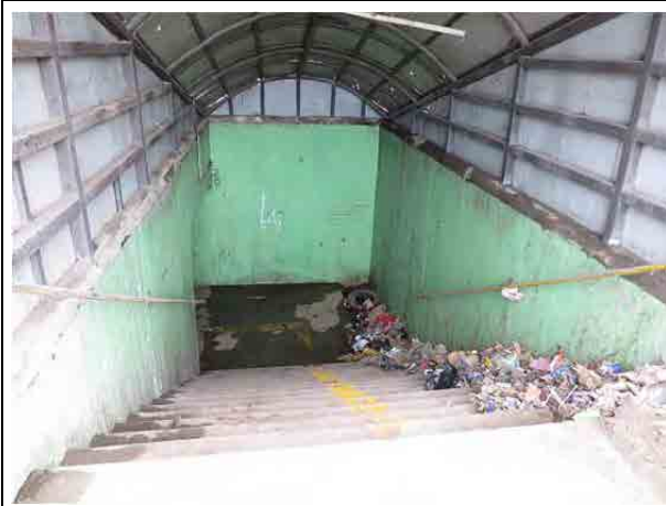
⑬横断地下道入口 (2014年3月時点) 地下道内部にはゴミが溜まり、照明が壊れているため暗くて通行できない。
