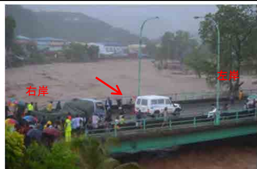
図 2-2-43 2014年4月の洪水の状況 (新マタニコ橋の下流から2014年4月3日に撮影) 橋梁の右岸側護岸工が洪水により浸食されている。
