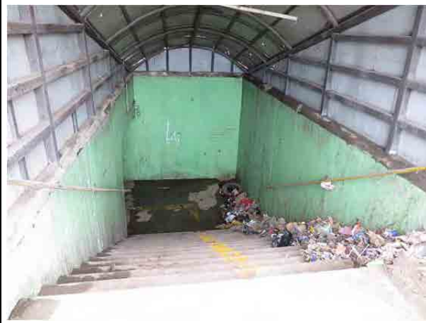
⑬横断地下道入口（2014年3月時点） 地下道内部にはゴミが溜まり、照明が壊れているため暗くて通行できない。
