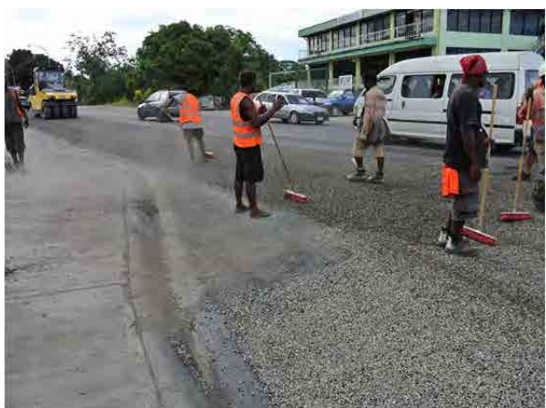
⑫道路補修状況（Sta. 0+500km） MIDによる舗装補修作業。定期的に補修が行われている。
