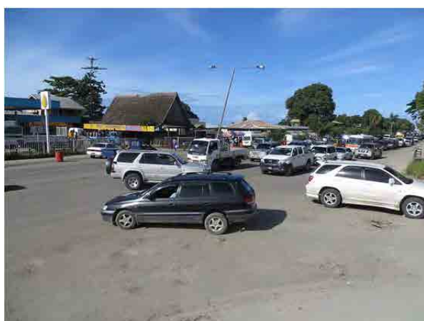
⑤ブラ交差点 (Sta. 2+500km) 信号機等の交通制御施設がないため、車両の錯綜が生じている。
