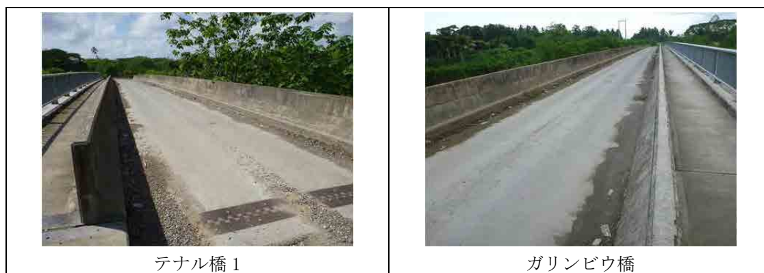
図 2-1-2 無償資金協力援助で建設された橋梁の現況
