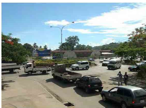
②市役所前ラウンドアバウト (Sta. 0+000km) ラウンドアバウトの容量不足のため一日中渋滞が発生している。
