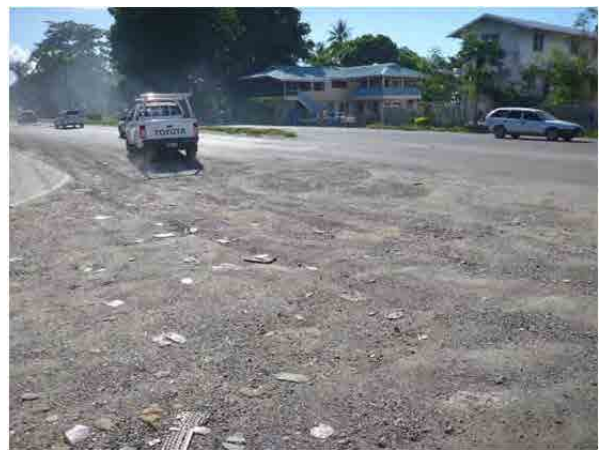
⑩T字交差点の舗装損傷（Sta. 1+700） 排水設備の不備により、アスファルト舗装が広範囲で破損している。
