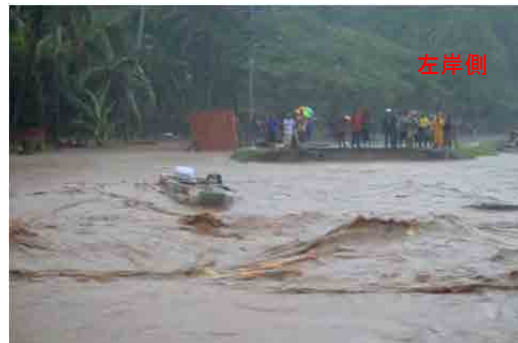
旧マタニコ橋上部工流失後 (2014年4月3日撮影)
