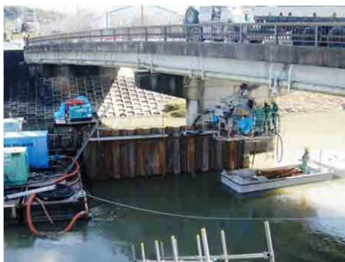
図 3-2-36 橋梁下での鋼矢板打設の例
