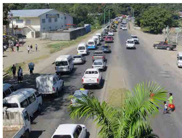
③新マタニコ橋付近 (Sta. 0+500km) 4車線道路に架かる新マタニコ橋での車線数が2車線であるため渋滞が発生している。
