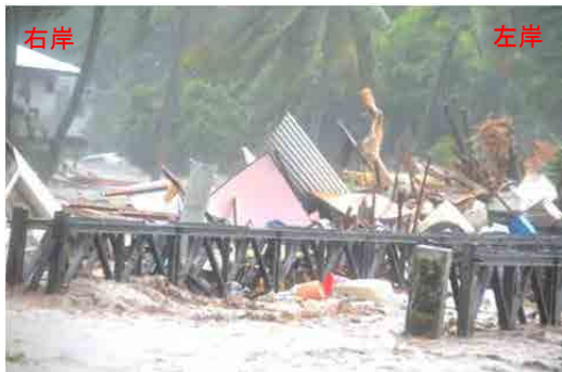
旧マタニコ橋に堰き止められた流下物 (2014年4月3日撮影)
