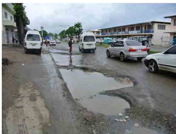
⑪バス停前の舗装損傷（Sta. 2+300） 排水設備の不備により、アスファルト舗装が破損し、雨水が路面に溜まっている。
