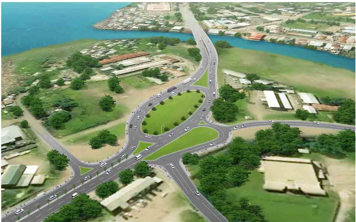
市役所前ラウンドアバウトの改良
