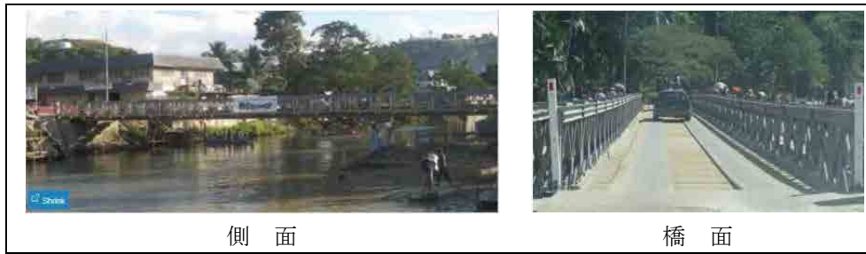
図 2-2-19 旧マタニコ橋の現橋写真
