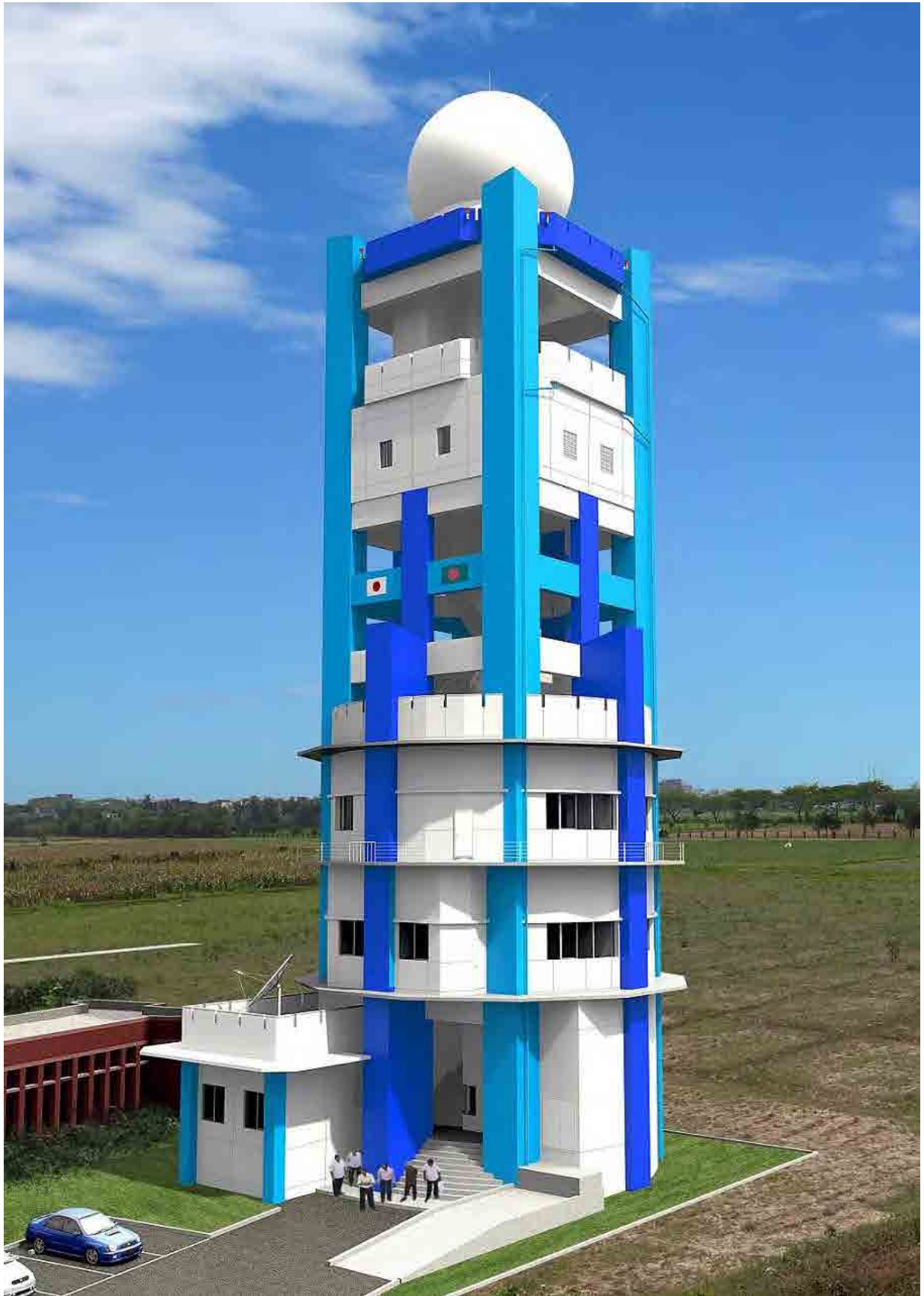
ダッカ気象レーダー塔施設（ジョイデプール）
