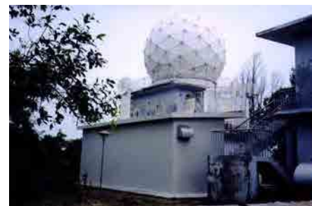
コックスバザール気象レーダー塔施設
