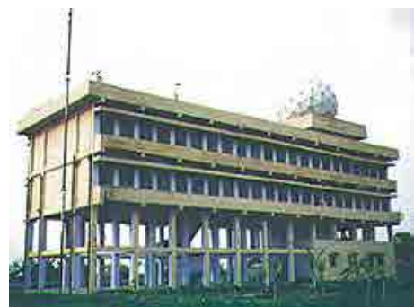
ケプパラ気象レーダー塔施設
