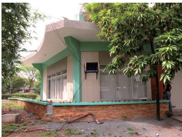
PAGASA 本部の敷地にある検定室
