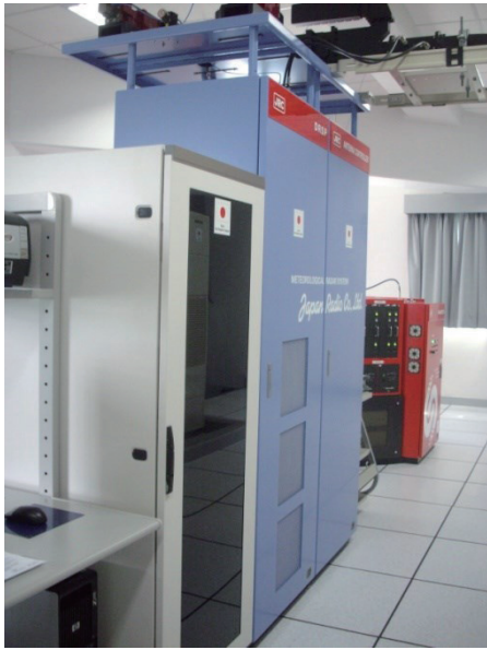
受信機と空中線制御装置
