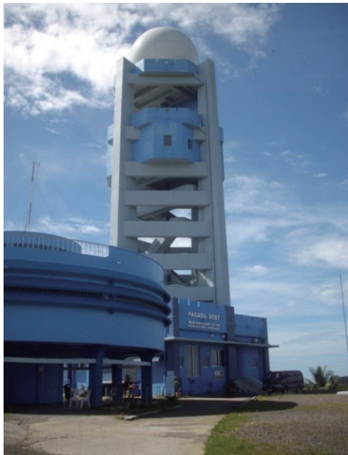
③無償資金協力により建設したビラク気象レーダー
