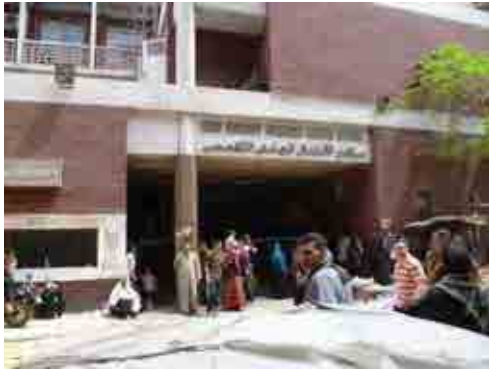
A メインエントランスの状況
