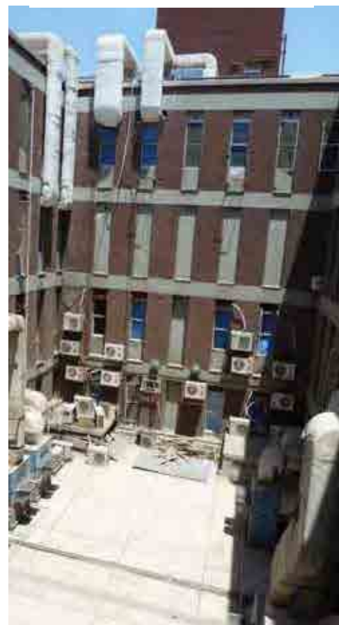
F 病棟中央吹抜け部
