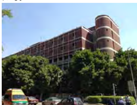
CUSPH 本院 無償資金協力にて1982年に建設、その後1988年、1996年に増築。
