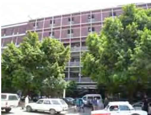
E 北側前面道路に面した駐車場出入口
