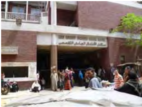
A メインエントランスの状況
