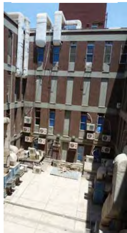
F 病棟中央吹抜け部
