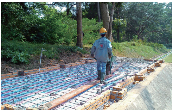
廃水処理パイロットスケールプラント建設中 ベトナム・ゴム研究所 (RRIV)
