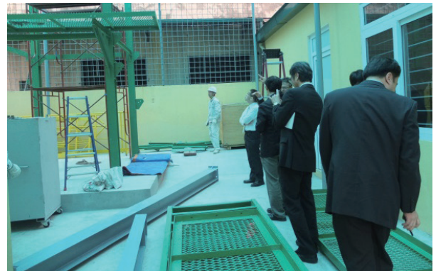
テストプラント建設中 (HUST)
