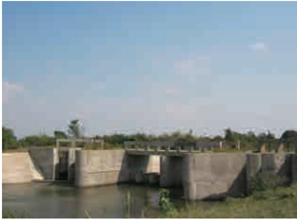
マナファ川基幹取水堰（AfDB の支援により建設） （2013 年 7 月 16 日）
