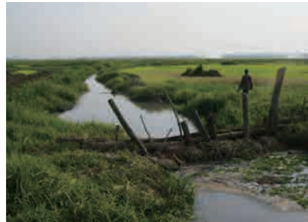
現地調達木材による仮設堰 (2013年7月16日)
