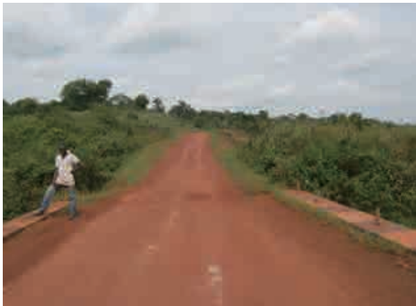
幹線道路の状況 (2013年8月1日)
