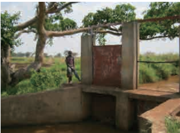
ActionAid (NGO) により 2006 年に建設された取水工 (2013年7月17日)
