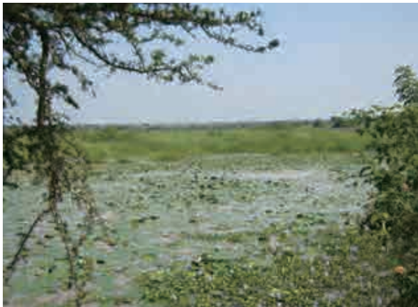
洪水吐が崩壊し貯留機能を失ったオミリオ貯水池 (2013年7月22日)
