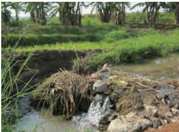
用水反復利用のため排水路内に建設された仮設堰 （2013 年 7 月 16 日）
