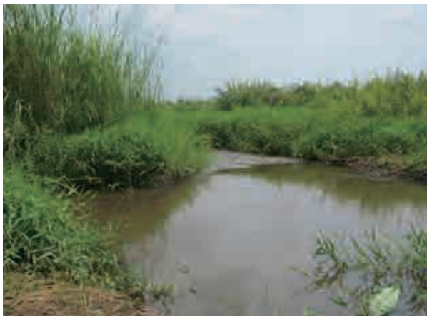
シピ川の仮設堰（JICA 支援サイトの下流） (2013年7月18日)
