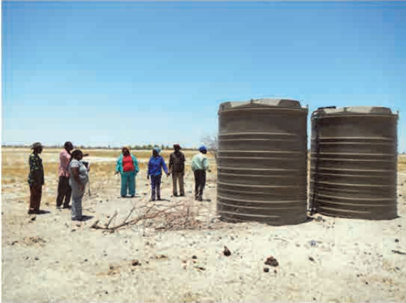
政府によって設置された給水ポスト
