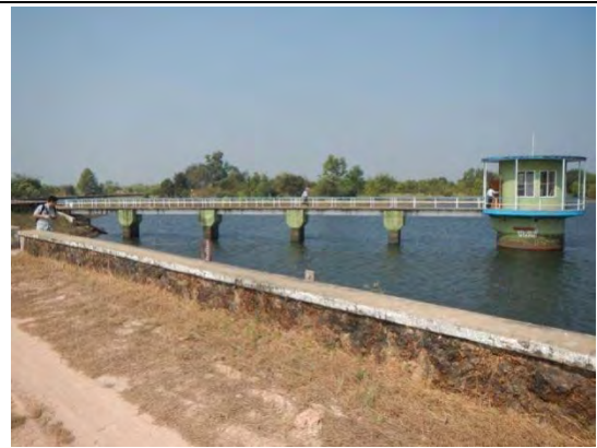
図 6-3-6 ラグンビン貯水池の取水塔
