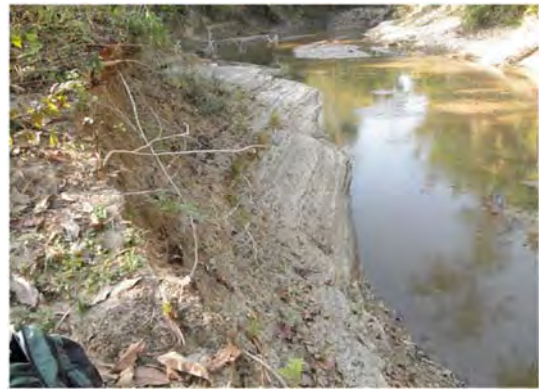
図 6-4-8 ダム現場左岸部
