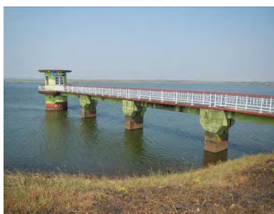
図 6-3-12 アライニ貯水池の取水塔
