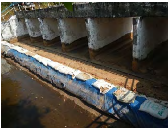
図 6-3-7 ラグンビン貯水池の洪水吐越流部
