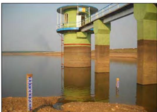
ラグンビン地点の河川流量はダム下流地点で流路が分流・分散することから、適当な流量観測点が見いだせなかった。このため、貯水池の水位を時系列で観測し貯水量の変化を求め、これと放流量、洪水量などのダム運用記録から推計することとした。自記水位計はダム堤体より張り出した取水塔に設置した (図 4-4-4-5 参照)。
