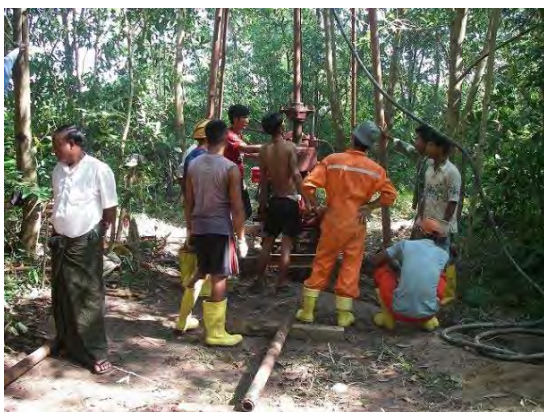
コアボーリング実施状況 (D-2 サイト)。 2013年2月撮影
