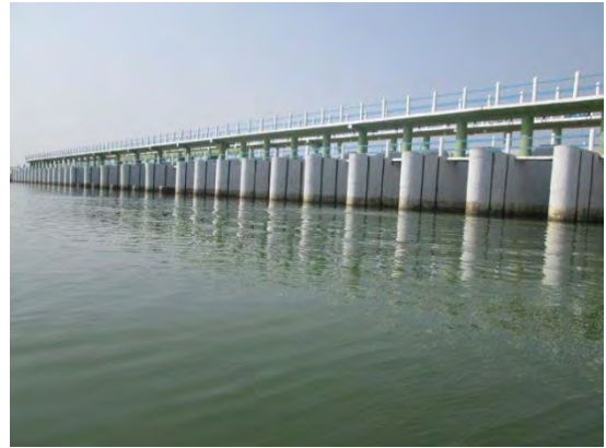
カヤン水門。2012年3月より供用開始。 2014年1月撮影
