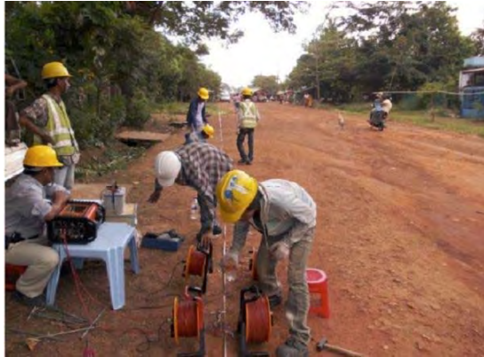
電気探査実施状況。 2012年10月撮影
