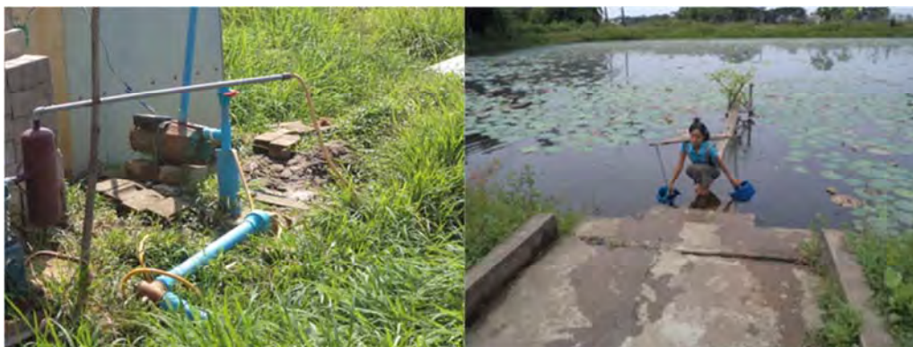
エアリフトポンプ使用の管井 (タンリン地区)
