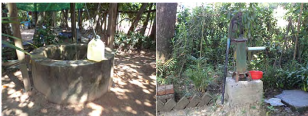
手押しポンプ使用の掘井戸 (タンリン地区)
