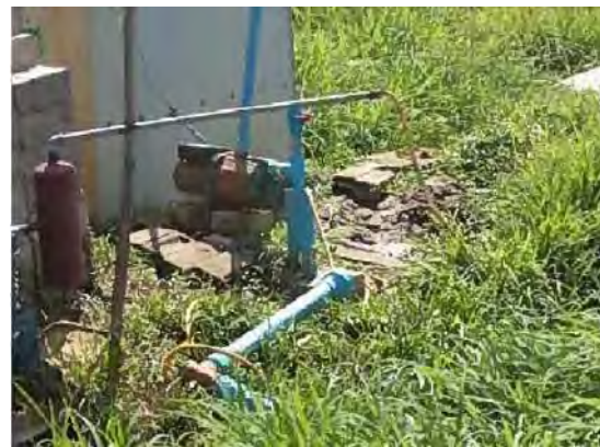
タンリン地区既設水源。家庭用深井戸 (小型エアーコンプレッサーで揚水) 2012年11月撮影
