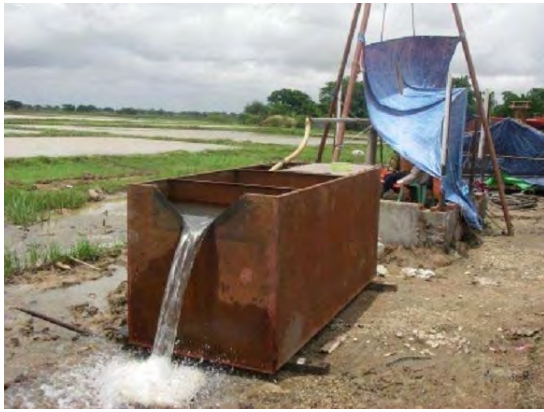
試験井戸の揚水試験実施状況 (D-3 サイト)。 2013 年 6 月撮影
