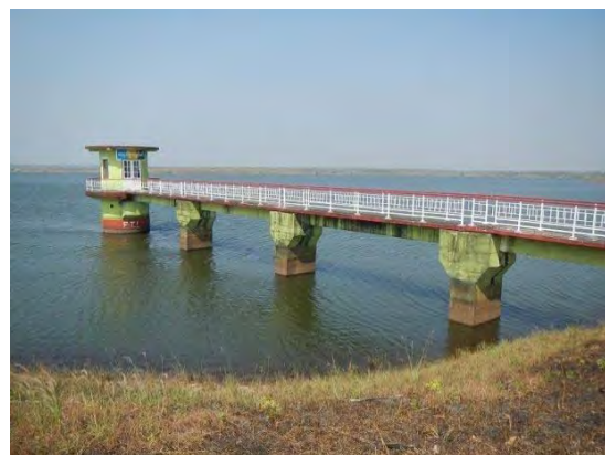
アライニ貯水池と取水塔。 2014年1月撮影
