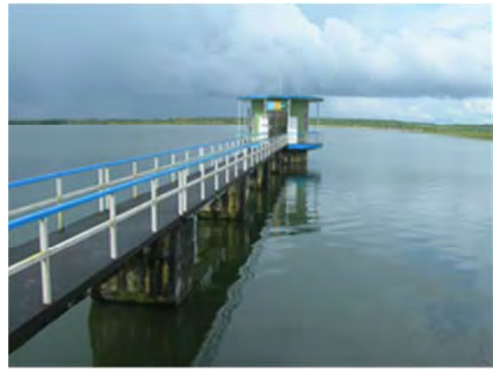
ラGUNビン貯水池の取水塔。高水位で運用されている。2012年11月撮影。
