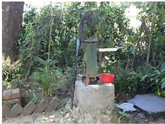
タンリン地区既設水源。ハンドポンプ付家庭用浅井戸。2012年11月撮影
