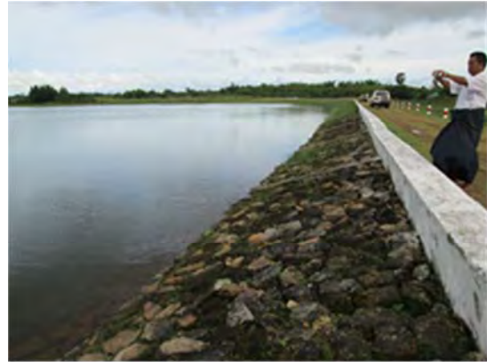
ザマニン貯水池。高水位で運用されている。2012年10月撮影
