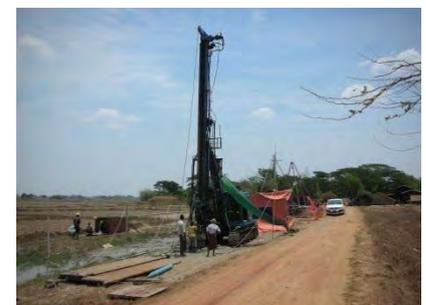
図 3-2-4 試験井掘削状況
