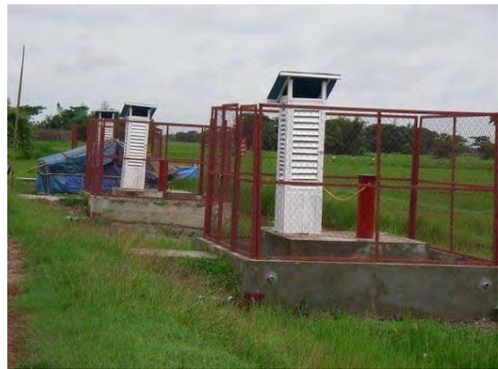
試験井戸掘削後の地下水位観測施設設置状況 (D-3 サイト)。
