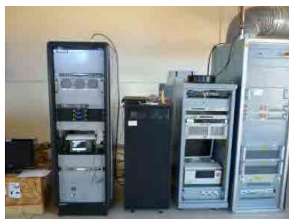
写真 11 実験用 ISDB-T デジタル送信機(左端)
