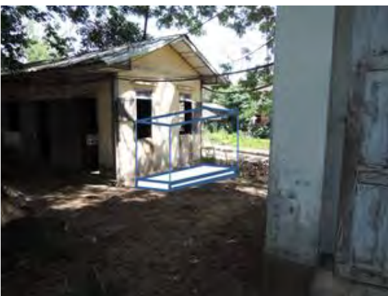
写真-47： 列車集中監視装置の駅装置の予備電源としてディーゼル発電機を設置する。(ピンポンジー駅)
