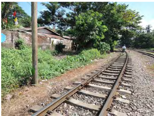
写真-27： ヤンゴン駅構内の線路の北側にパズンダン駅まで低圧電力ケーブルを埋設する。
