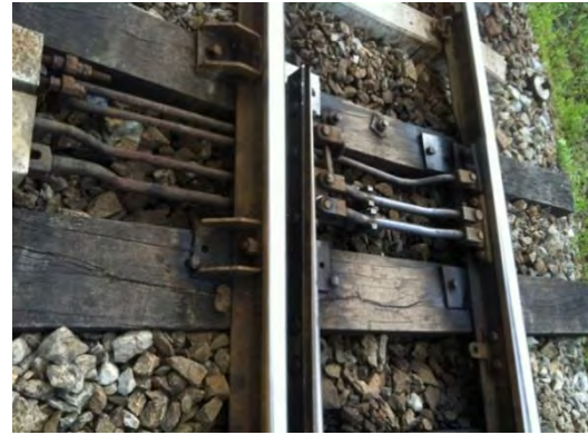
写真-20： 転つ木属装置。直接継ぎ式で、日本の一般的な仕様と違った形でトンダレールに接続されている。
