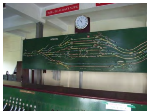
写真－４： 信号扱所内の表示盤。駅構内の連動範囲の列車在線位置を把握できる。パズンダン駅隣り外。
