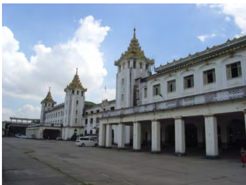
写真－１： ヤンゴン中央駅の本屋。駅の連動装置は英ウェスティンハウス製で、使用開始は1950年である。進路数は174ある。
