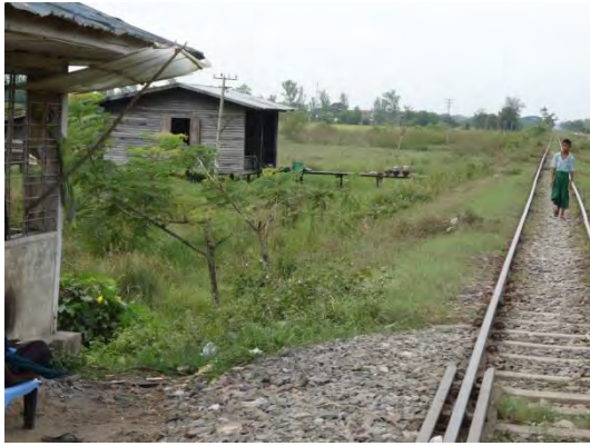
写真-37： 踏切制御装置及びディーゼル発電機の設置予定箇所。土留の施工が必要である。
