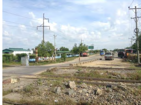
写真-32： 今回踏切の自動警報化を行うにあたり、JICAによる技術協力プロジェクトにて道床の整備が行われる予定。
