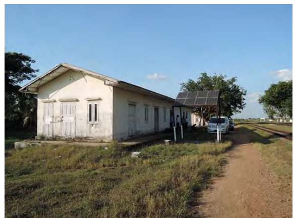
写真-48： 市中電力が無い駅には太陽光発電が設置されている。(ターワ駅)
