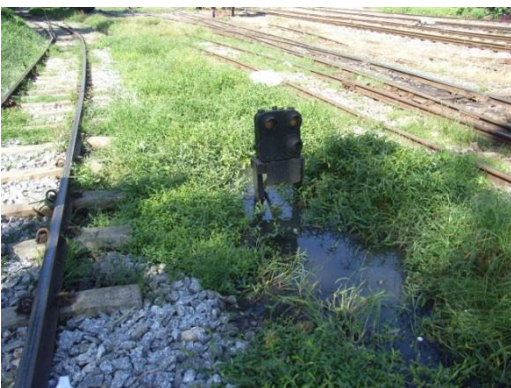
写真-11： 駅構内東南部は近隣のアパートなどからの生活排水が流れ込んでおり、写真のように入換信号機が水に浸かってしまっている箇所がある。
