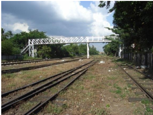
写真-15： ヤンゴン中央駅から1.6km離れたパズンダン駅構内。幹線とヤンゴン環状線の線路平面交差する。
