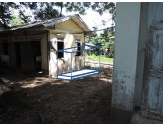
写真-47： 列車集中監視装置の駅装置の予備電源としてディーゼル発電機を設置する。(ピンポンジー駅)
