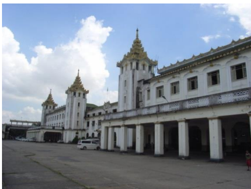
写真－１： ヤンゴン中央駅の本屋。駅の連動装置は英ウェスティンハウス製で、使用開始は1950年である。進路数は174ある。
