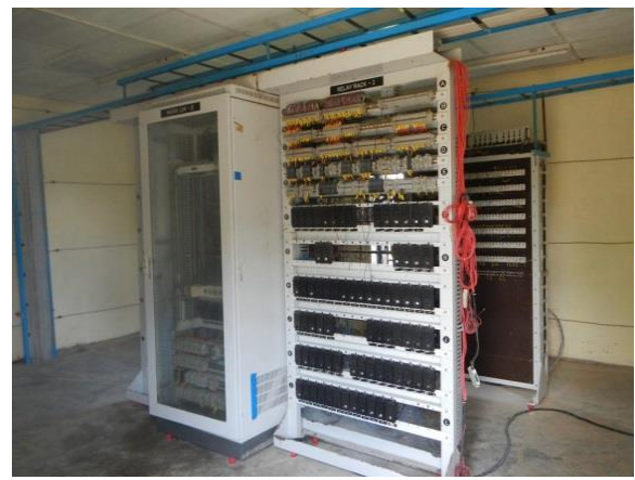
写真-40： TMS 駅装置を設置する駅で行われている電子連動装置 (SSI) 設置工事。この機器室のスペースにTMS 駅装置を設置する。(リーダウカン駅)
