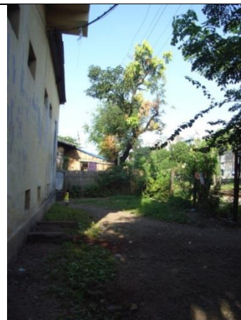
写真-24： バズンダン駅における新信号機器室予定地。現在の信号所がある建物の隣の空き地で約50㎡の平屋の建物を設置する計画である。
