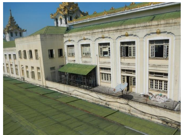
写真-30： ヤンゴン中央駅現行信号扱所から、新しく設ける信号扱所・信号機器室を見たところ。ケーブルは写真の現行と同じルートを使用する。
