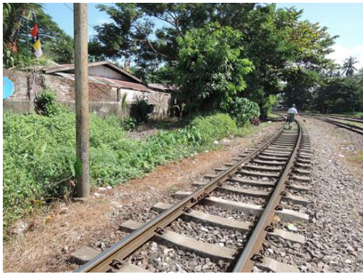
写真-27： ヤンゴン駅構内の線路の北側にパズンダン駅まで低圧電力ケーブルを埋設する。
