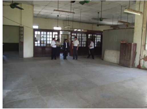
写真-14： 予定箇所内部。ここに新信号扱所、新指令所(OCC) 新信号機器室を設ける。
