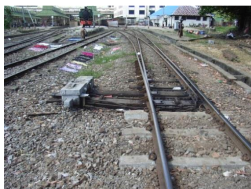
写真－６： ヤンゴン中央駅構内の東側の駅設備。線路内は一般人が自由に立ち入っており、生活の場となっている箇所もある。
