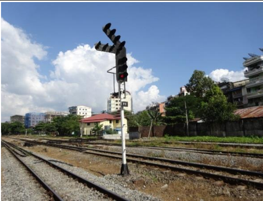
写真-21： 独式の信号機構で、進路表示器と一体となっている。信号現示はLED化されている。
