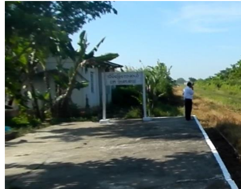
写真-46： エインチェリセ駅に接続架がない為、既設光ケーブルを地中より割り出して接続する工事が必要である。接続工事予定箇所付近の通話機器室
