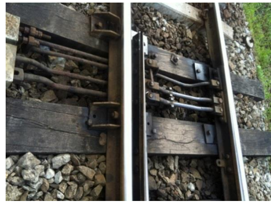
写真-20： 転つ木属装置。直接継ぎ式で、日本の一般的な仕様と違った形でトングレールに接続されている。
