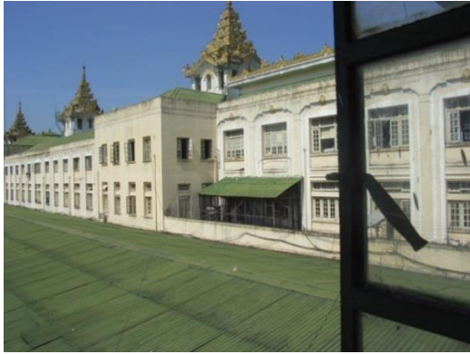
写真-13： 現信号扱所から新信号扱所予定箇所を臨む。駅本屋3階に位置する。
