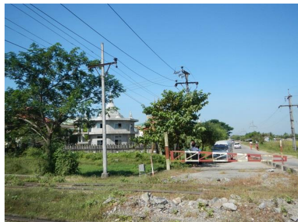
写真-36： 遮断機の設置予定付近に、送電線があり、遮断棒と接触する恐れがある。
