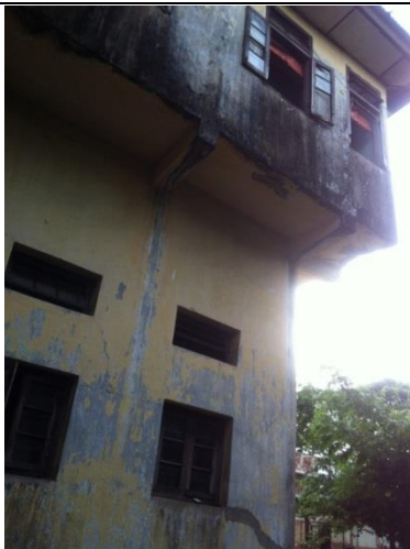
写真-17： パズンダン駅信号扱所の外観。上が信号扱所で、その下が信号機器室となる。
