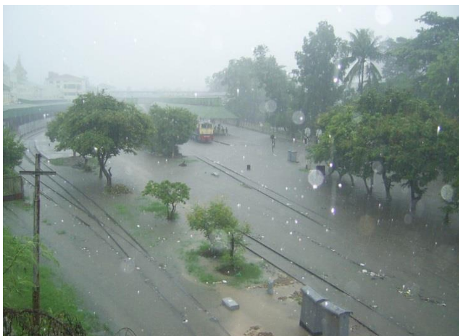
図. 3-4 線路冠水状態（駅中央付近）
