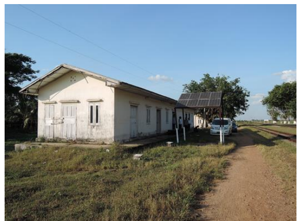
写真-48： 市中電力が無い駅には太陽光発電が設置されている。(ターワ駅)
