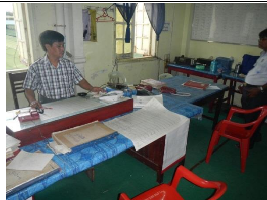
写真-42： 現行のバゴ管区OCCの指令卓。列車位置の把握は電話のみによって行われるので時間を要し、かつタイムラグが生じて正確な把握出来ない。
