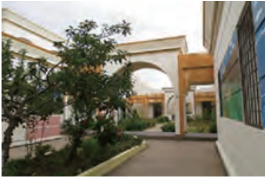
中学校 Sidi Kacem Collegial Dakhla 校舎 (10/4)
