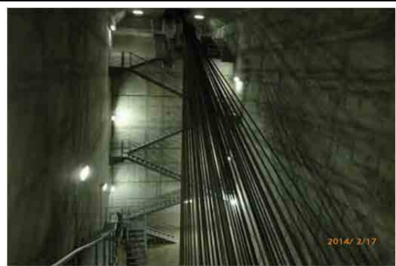
Vue d'ensemble de l'espace en biseau : dans la moitié droite de la photo, un câble porteur.
