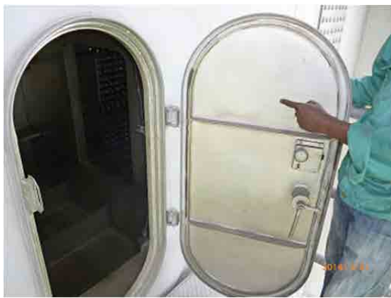
Porte d'entrée de l'entretoise d'un pylône. Il est prévu d'apporter les équipements par cette voie.
