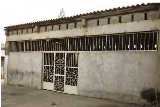
Bâtiment prévu pour la mise en place du nouveau panneau de réception électrique
