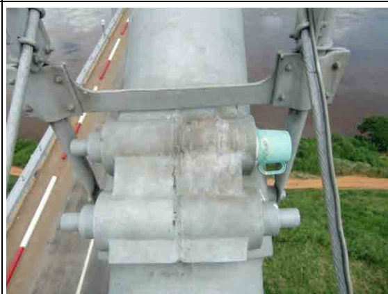
ボルトキャップに応急的にコップが代用されている。
