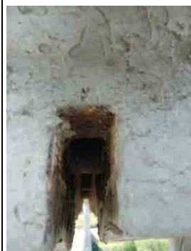
センターバンド下部溝の状態。現在開放され、ワイヤーに赤錆が見られる。
