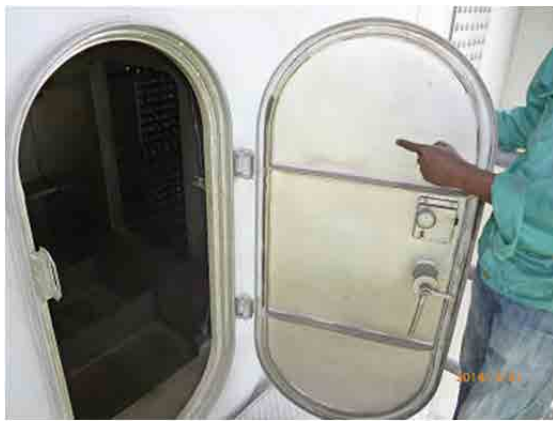
塔の水平材入口扉 ここから設備を搬入予定。
