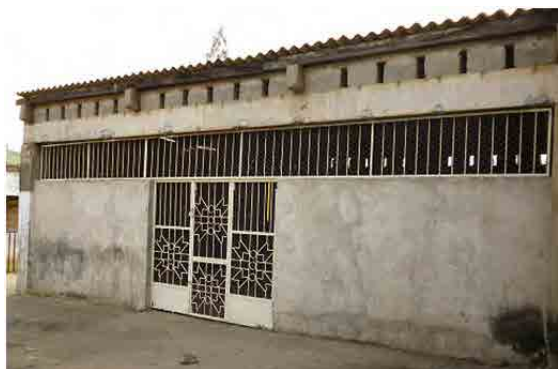
新しい受電置予定の建物。
