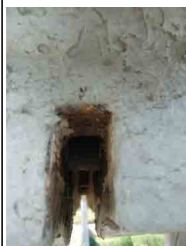
センターバンド下部溝の状態。現在開放され、ワイヤーに赤錆が見られる。
