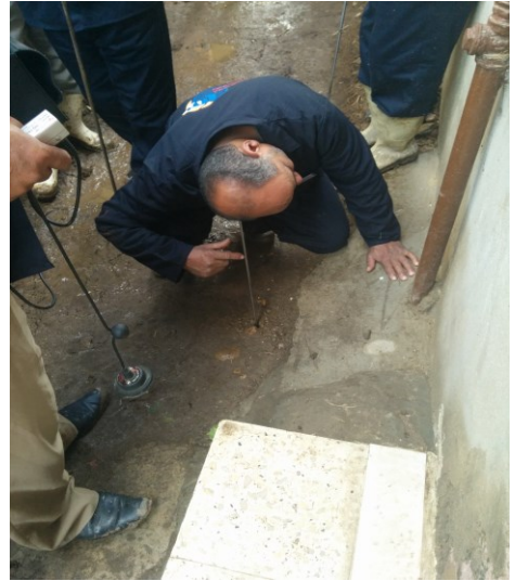
ガルビーヤ県サンタ郡における漏水探知活動の様子。音聴棒を用いて給水管の漏水音を聞き取っている。
