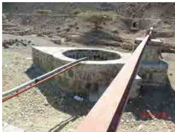
Travaux de protection du puits (site Hambokto)
