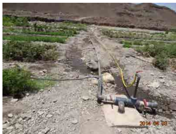
Goutte-à-goutte (site Afka Arraba)
