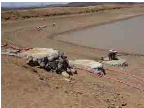
Prise d'eau (site Kourtimalei)
