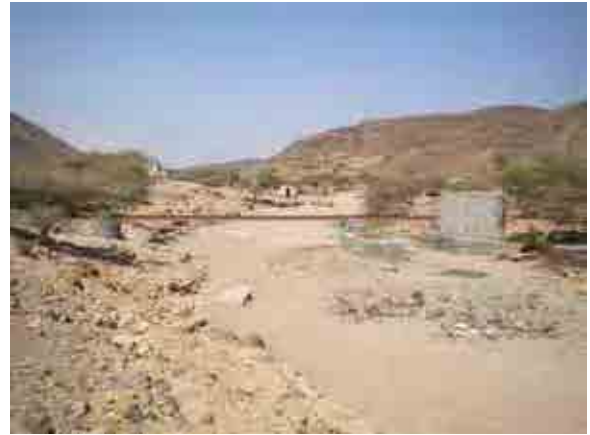
Intake Works (Hambokto)
