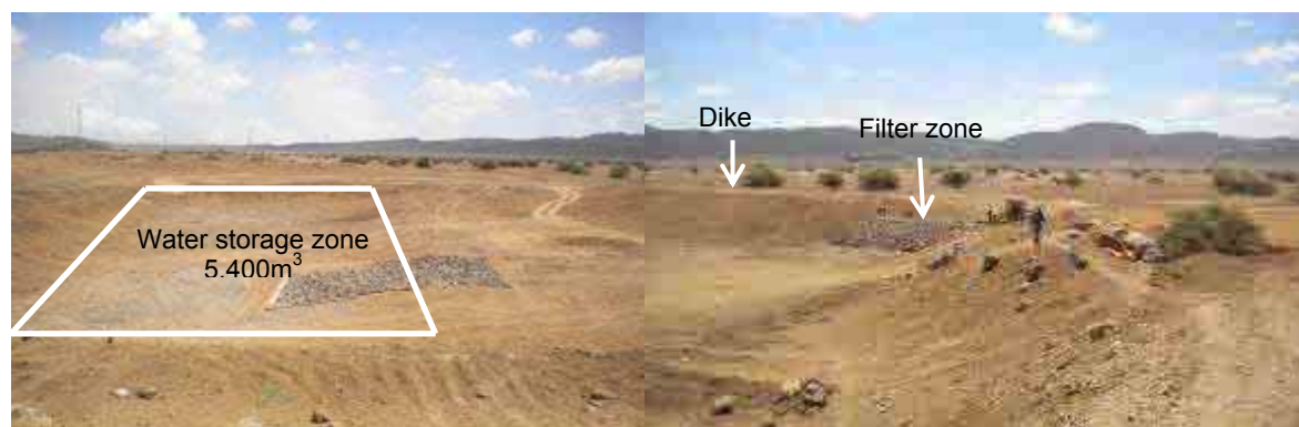
Kourtimalei 溜池の改良工事（2012年6月）
