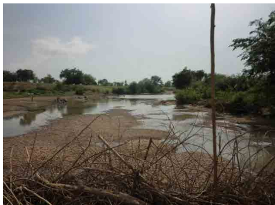
Photo 3 Ouvrage traversant la rivière en amont
