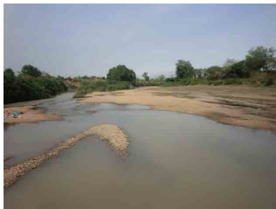
Photo 4 Ouvrage traversant la rivière en aval
