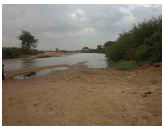
Photo 6 En aval du pont
